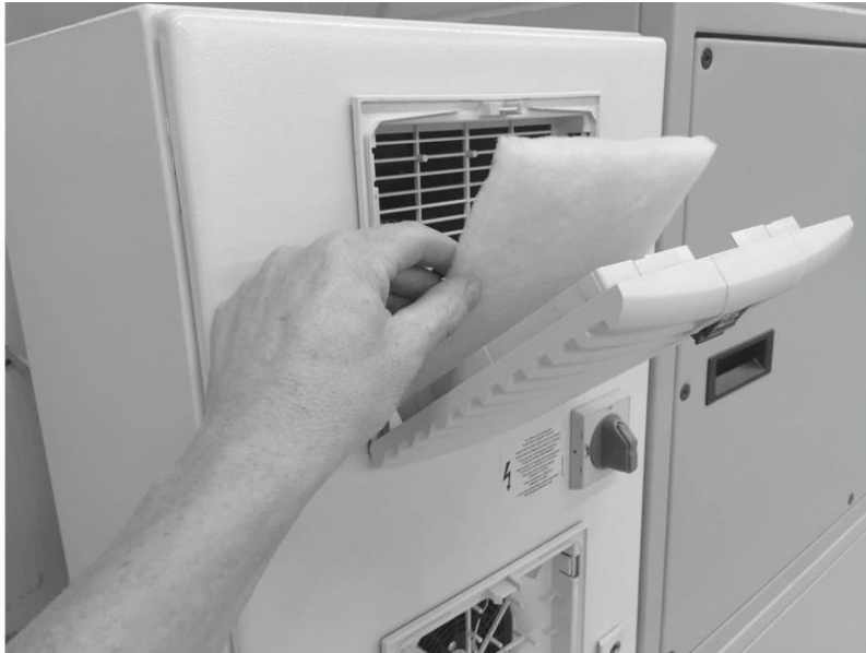
Fig. 39: filterbytte koblingsskap
